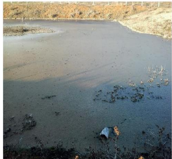
Şekil 1. Filtre Malzemesi Tıkanıklığından Kaynaklanan Göllenme Gözlenen YSA [17]
