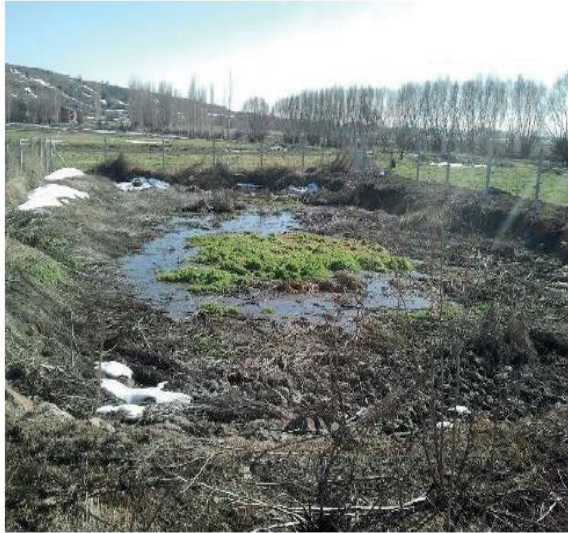
Şekil 1. Filtre Malzemesi Tıkanıklığından Kaynaklanan Göllenme Gözlenen YSA [17]
